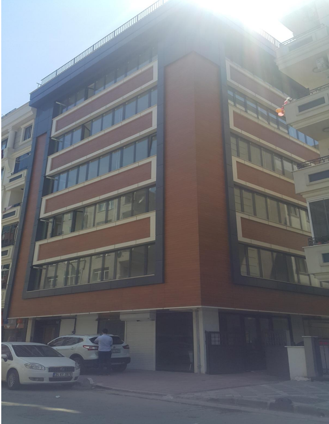
Yapının Saray Caddesinden Görünümü
